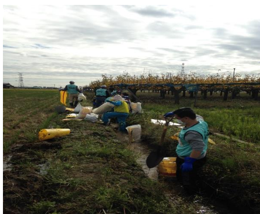
側溝清掃、まずは溜まっている水を排水
