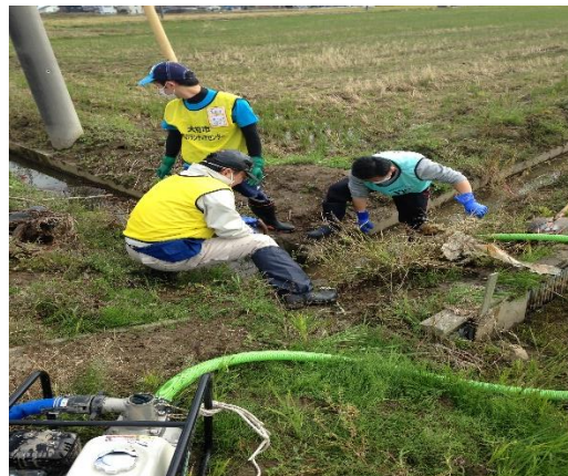
側溝清掃、まずは溜まっている水を排水
